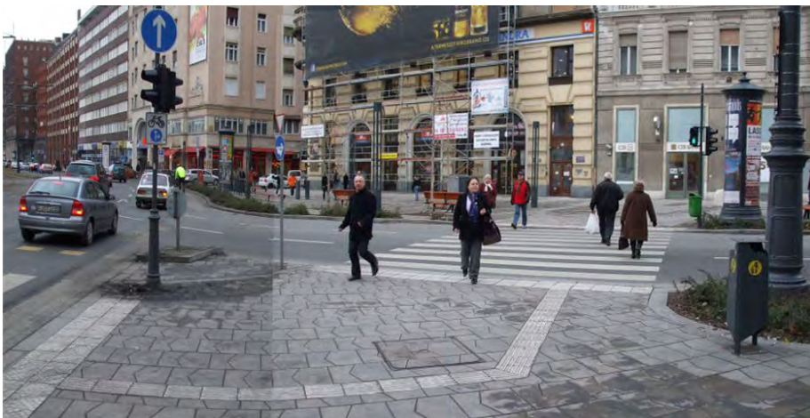
287-288. a rávezetés az átkelő tengelyével párhuzamos, és az átkelő két oldalán egymással szemben található
