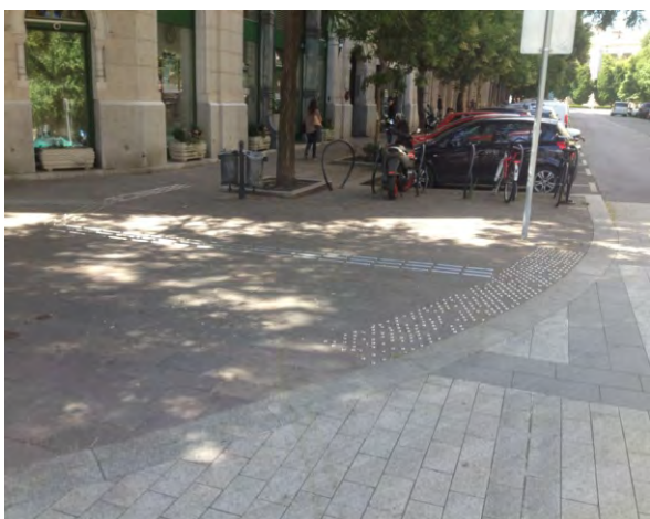
310-312. az utólag elhelyezett jelzésrendszer foghíjas, nincsen fenntartva; a csomópontokban ma már nem használatos a figyelmeztető jelzés
