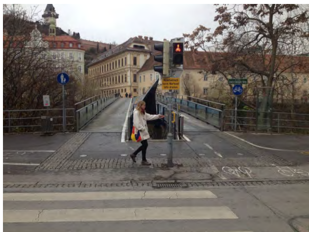
392. CWSM vezető- és figyelmeztetősáv gyalogátkelőnél
