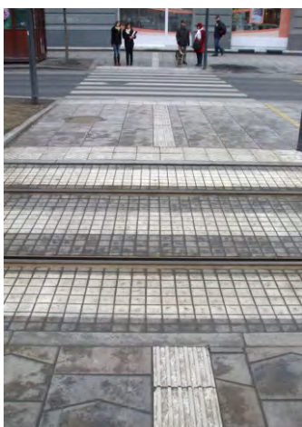
299-300. nem követték a terveket: a vezetősáv átkelőknél mindig figyelmeztetősávba fusson! magán az átkelőn hazánkban nincs vezetősáv
