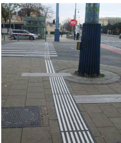
375-377. színkontrasztos TWSI, csak vezetőelemekkel, az átvetés magán az útpályán is adott (hazánkban ez nem terjedt el)
