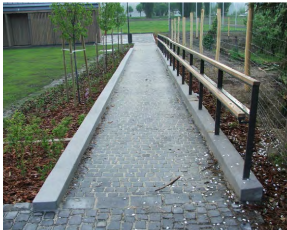
78-80. akadálymentes rámpa szolgál a lépcső (ld.56-57.) alternatívájaként, kerékvető és duplasoros korlát, amelyen a kéz nem akad meg
