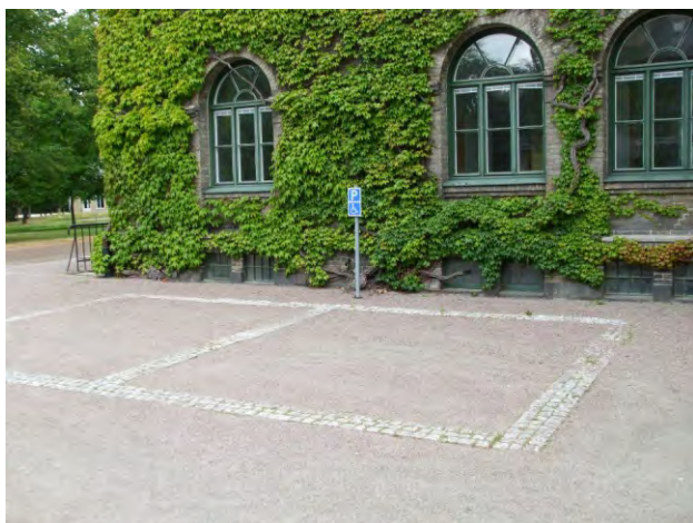
592. akadálymentes parkoló stabilizált burkolaton
