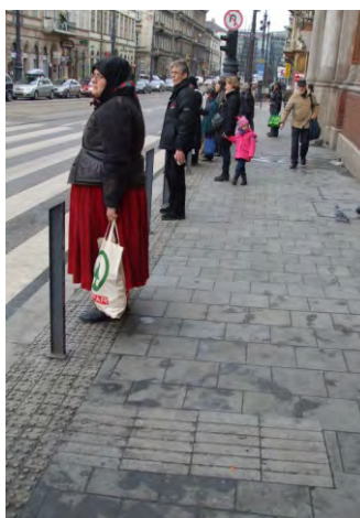
266-268. 2010-ben vezetősávot helyeztek el a kiskörúton figyelmeztető funkcióba, majd az érintettek észrevételei alapján ezt javították
