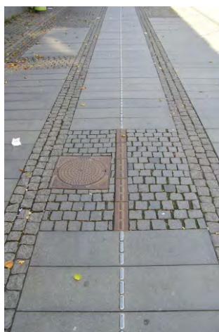
242-245. terméskő burkolatba integrált egyedi taktilis jelzésrendszer; egy vezetőborda nem érzékelhető; a fenntartás hiánya
