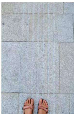
208-211. a burkolatba mart kialakítású vezetősáv nem érzékelhető, és kültérben hajlamos az eltömődésre; hiányzó szinkontraszt
