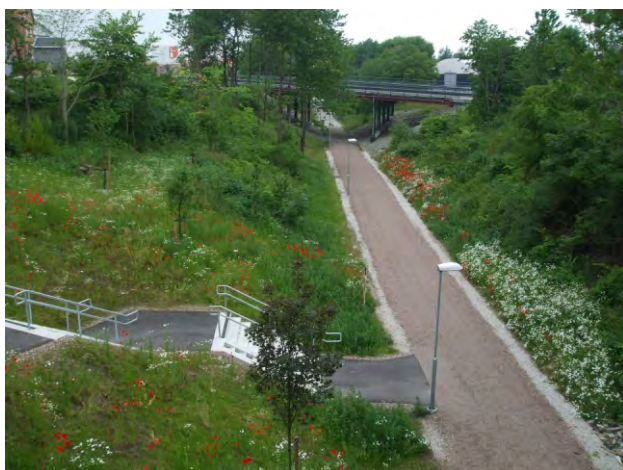
523. jól karbantartott kerékpárút stabilizált burkolaton
