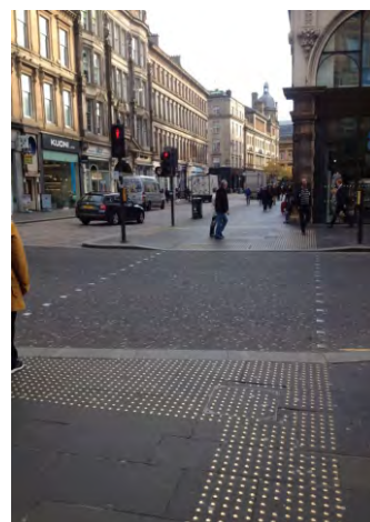
358-360. a rávezetés is figyelmeztetőelemekkel történik; az átkelést az útburkolaton nem jelölik, így hiányzik a vizuális kontraszt
