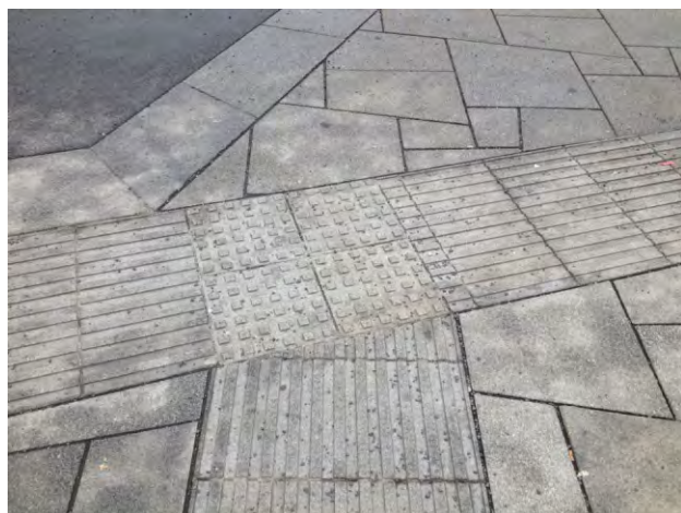
382-383. ...a magyarországi felfogásban a vezetősávba nem eshet objektum (=akadály); az elágazásoknál figyelmeztető jelzés
