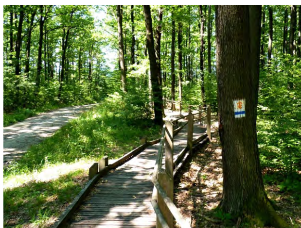
773-774. a pallóút kerékvetője lehet indokolt és lehet akadály; ahol maga a meglévő út is használható, felesleges a beruházás
