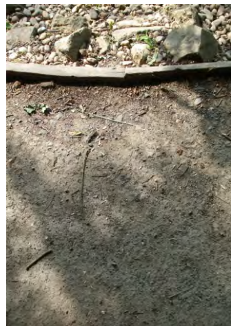
725-727. nagyobb frakciókat is tartalmazó, emiatt kerekesszékekkel nehezebben használható stabilizált burkolatok
