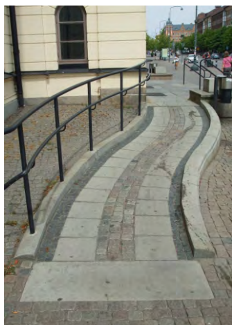
101-103. előlépcső és rámpa, a rámpa íves (kérdés: megfelelő-e a sugar-lejtés aránypár, vagy torzul a felület?), szíkontrasztos éljelölés
