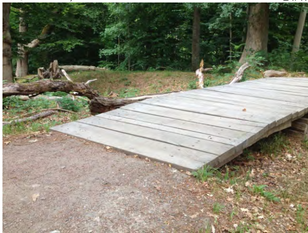
672-673. a mindkét oldalon szintben csatlakozó híd alkalmas az akadálymentes használatra
