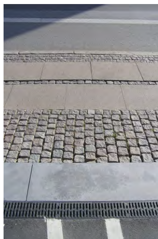
189-190. a különböző burkolatok következetes váltása orientál
