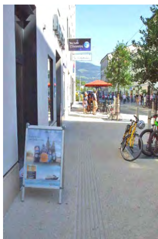
208-211. a burkolatba mart kialakítású vezetősáv nem érzékelhető, és kültérben hajlamos az eltömődésre; hiányzó szinkontraszt
