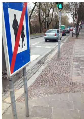
389-391. CWSM vezető- és figyelmeztetősáv teresedésről megtalálandó gyalogátkelőhöz
