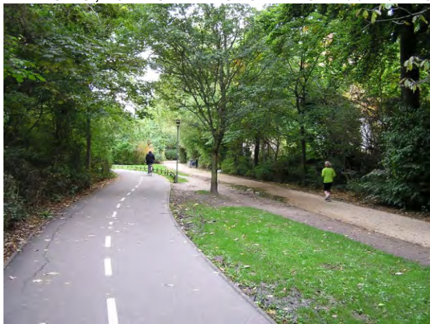
528. a gyalogút stabilizált, a kerékpárút aszfalt burkolatú
