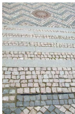
53-54. nem érzékelhető, balesetveszélyes lépcsős szegély / lépcső
