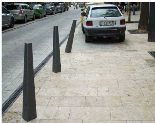
398-400. Pest új főutcájában a pollerek dőlési iránya esetleges (kivitelezési hiba), ami nehezíti a (párhuzamos) parkolást; fa takarja a táblát
