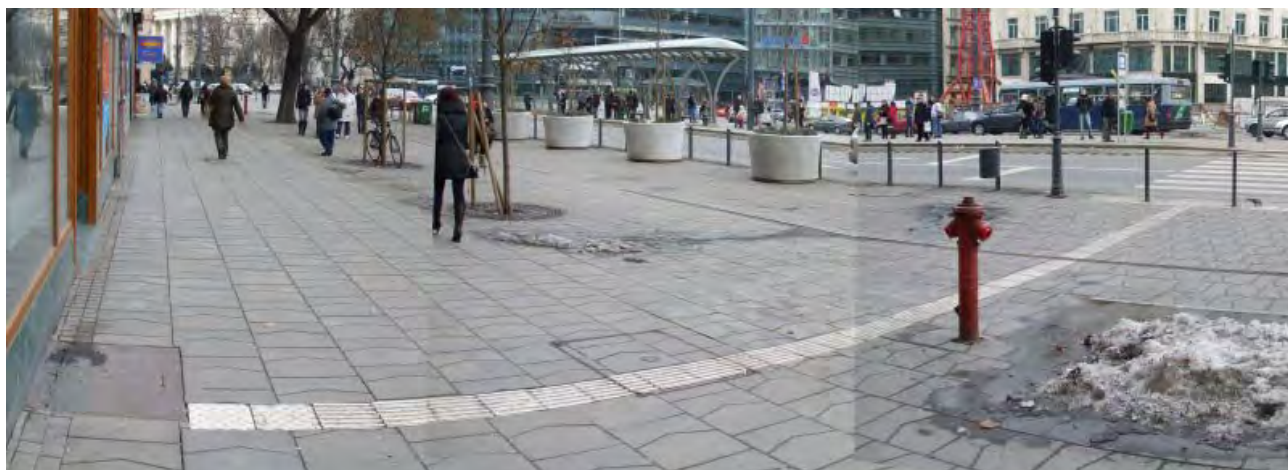
289. az átkelő megtalálásának érdekében a rávezetőszáv a járda teljes szélességében húzódik (ma már visszafogottabb az alkalmazás)
