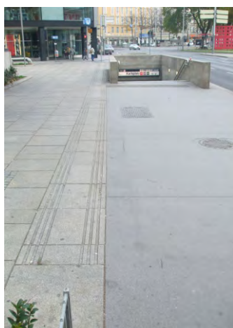
225-227. a Bécsben használt, csak taktilis kontrasztot nyújtó jelzésrendszer egyedi vezetőelemmel
