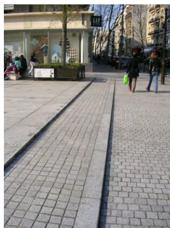
69-70. figyelmeztetőjelzés szélessége az érzékelhetőséghez min. 60cm
