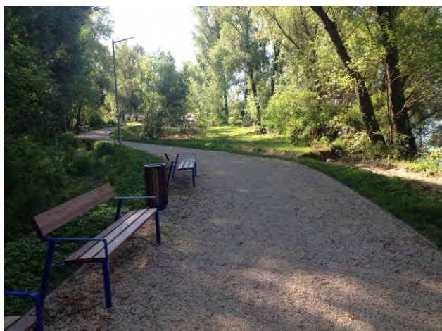
728-729. kavicsfix-burkolat parti sétányon, amelyet gördülőeszközökkel is akadálymentesen lehet használni
