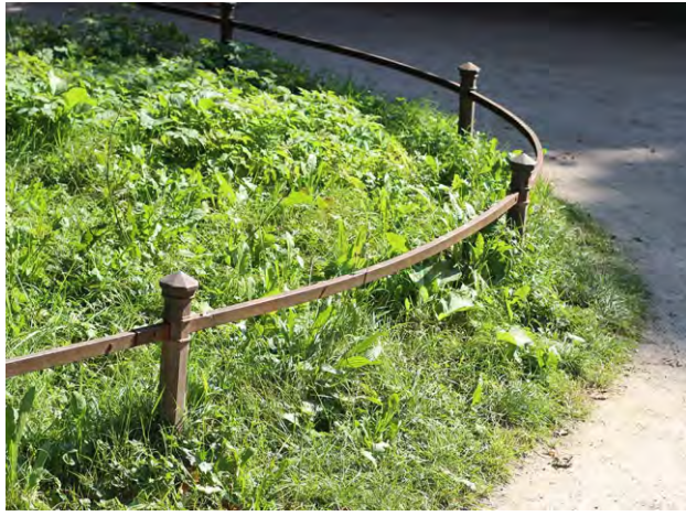
571-572. a stabilizált burkolattal kontrasztos szegély, ill. a kapcsolódó növényfelületek mellett terelőelemek is alkalmazhatók orientálásra
