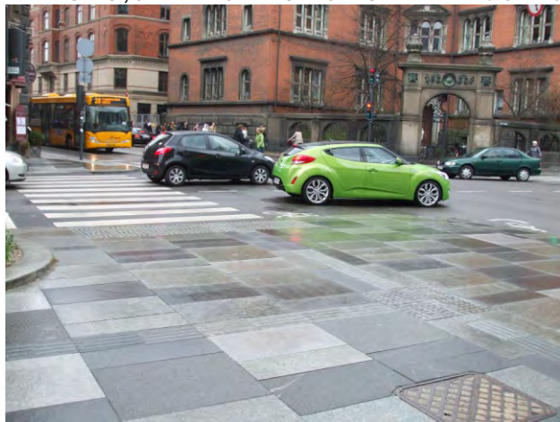
338-339. a burkolati rendszerbe illő egyedi taktilis jelzésrendszer; a vizuális kontrasztot az átkelő útburkolati színezése adja
