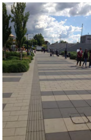
249-251. közlekedési csomópontban gondosan tervezett, orientáló burkolatminta és abba ízesülő taktilis jelzésrendszer
