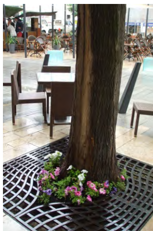
111-114. a meglévő fák törzsének szűkös a beépített faveremrác; a fiatal fa törzse sérülni fog; a földlabdás növény rosszul elültetve
