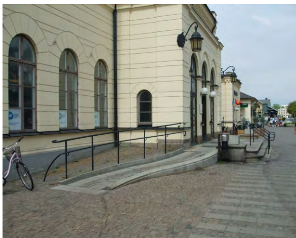
101-103. előlépcső és rámpa, a rámpa íves (kérdés: megfelelő-e a sugar-lejtés aránypár, vagy torzul a felület?), szíkontrasztos éljelölés
