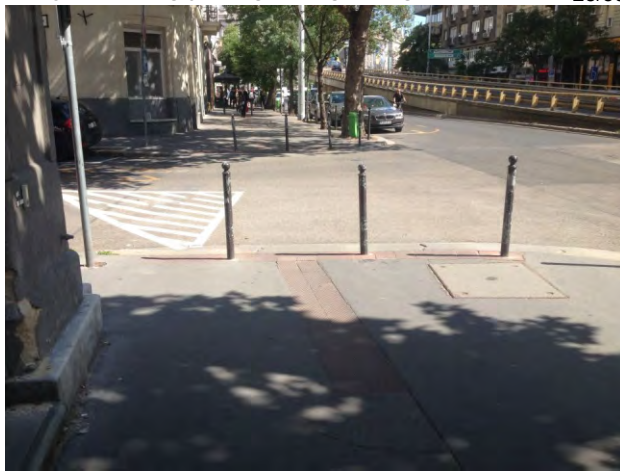
252-253. kezdetekben a KK Párizs jelzőkő volt a taktilis jelzés Magyarországon, de a színe és a felületi érdessége nem bizonyult alkalmasnak
