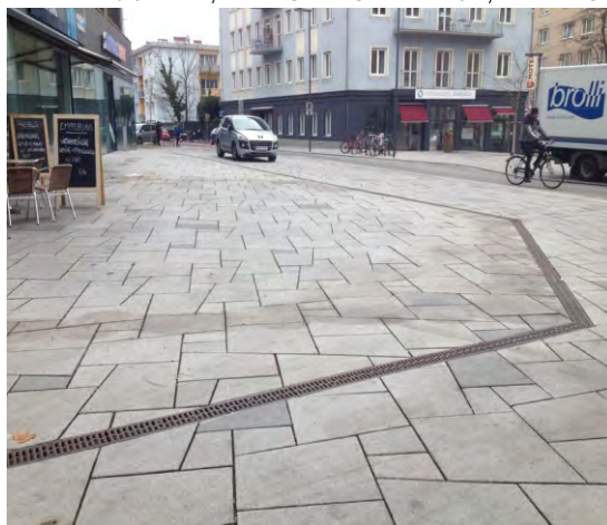
205-207. a vonalas vízvezető rácsokat sok látássérült ember használja természetes vezetősávként (rácsköz < 2cm)
