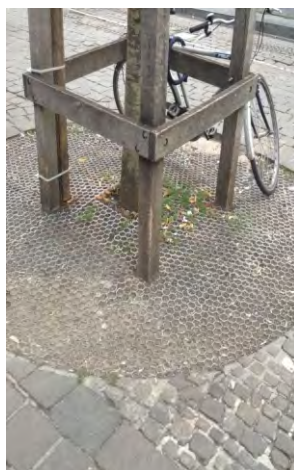
122-123. vízáteresztő, de járható burkolattal képzett favermek
