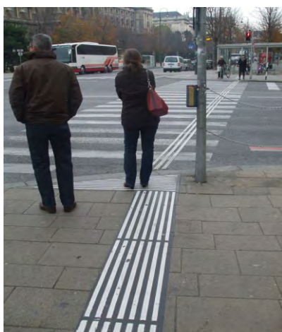
375-377. színkontrasztos TWSI, csak vezetőelemekkel, az átvetés magán az útpályán is adott (hazánkban ez nem terjedt el)
