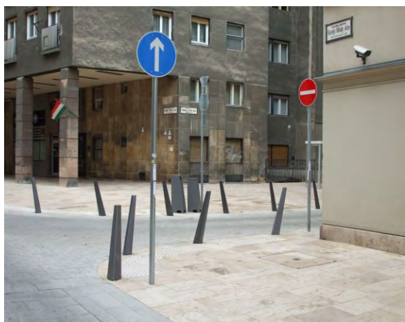
277-279. a figyelmeztetőelemek kialakítása lehetővé teszi az ívek kirakását; a ferde pollerek a közlekedés szelvényébe lógva veszélyesek
