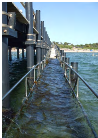
693-695. a kerekesszékkal való vízhez jutást segítő stég és rámpa
