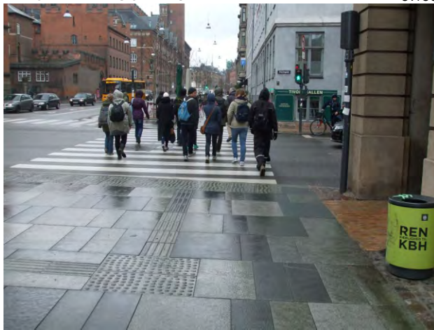
338-339. a burkolati rendszerbe illő egyedi taktilis jelzésrendszer; a vizuális kontrasztot az átkelő útburkolati színezése adja
