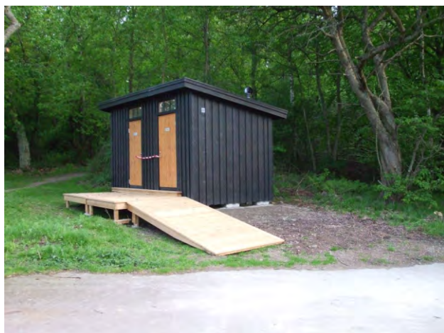
811-812. a rámpa adott, de a terepcsatlakozás nem akadálymentes
