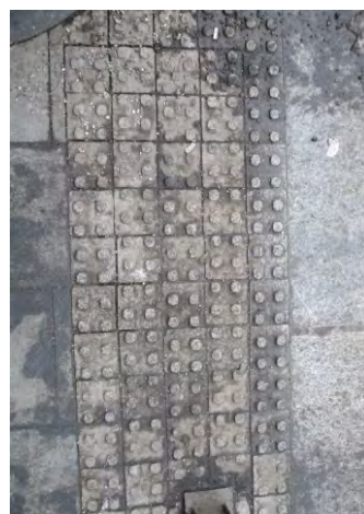
266-268. 2010-ben vezetősávot helyeztek el a kiskörúton figyelmeztető funkcióba, majd az érintettek észrevételei alapján ezt javították
