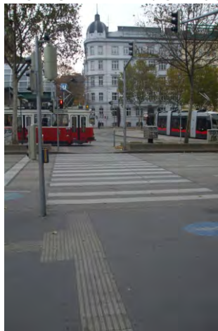
366-368. csekély színkontrasztú TWSI Bécsben; figyelmeztetéskeresztbe fordított vezetőelemekkel
