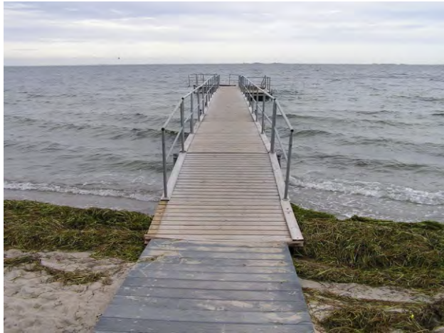
680-681. a kerekesszékkal való vízhez jutást segítő stég és rámpa
