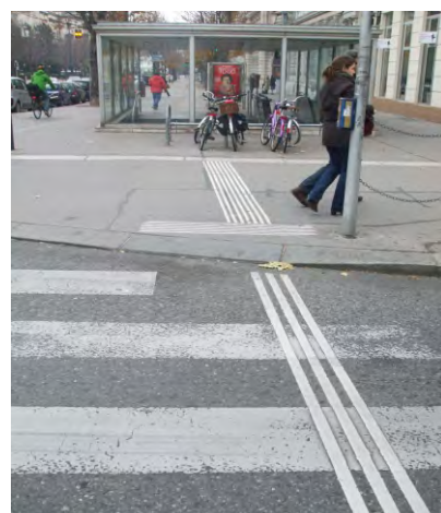
375-377. színkontrasztos TWSI, csak vezetőelemekkel, az átvetés magán az útpályán is adott (hazánkban ez nem terjedt el)
