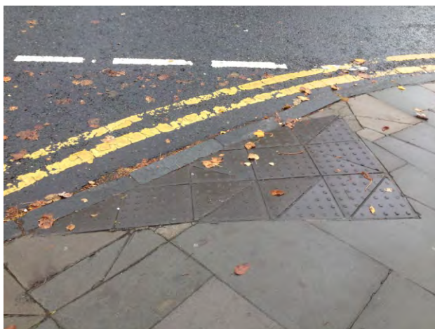
352-353. különböző kialakítású TWSI-k skóciai gyalogátkelőknél; az átkelés nem zebrával, hanem vörös színnel jelezve
