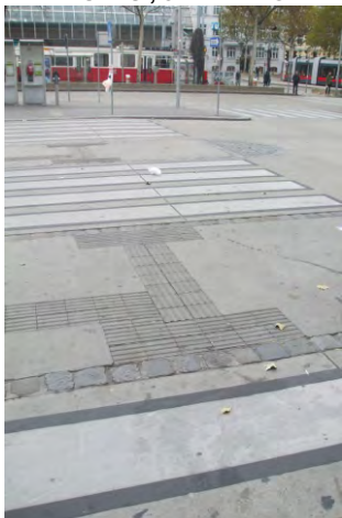
366-368. csekély színkontrasztú TWSI Bécsben; figyelmeztetéskeresztbe fordított vezetőelemekkel
