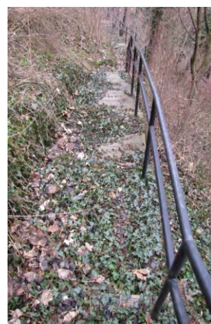
516-519. a lépcsőket kontrasztosan jelölni szükséges, ahol a leesés veszélye fennáll; a takarítás és fenntartás is nagy fontosságú
