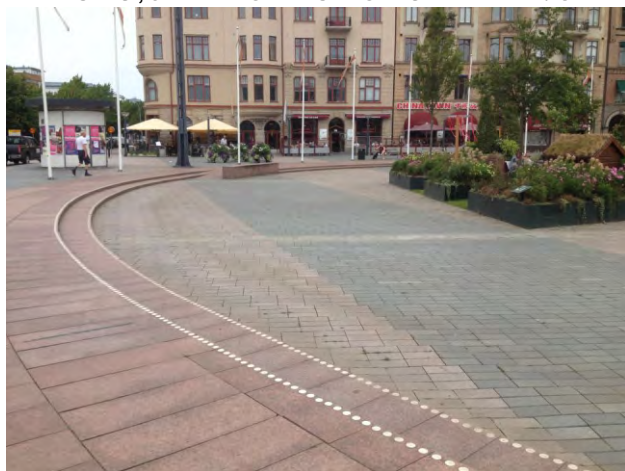
66-67. lépcsőbe integrált rámpa kontrasztos színezésű éljelöléssel, taktilis jelzés nem található
