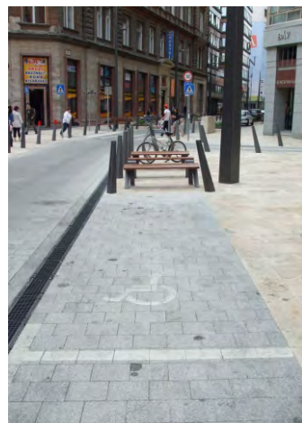
398-400. Pest új főutcájában a pollerek dőlési iránya esetleges (kivitelezési hiba), ami nehezíti a (párhuzamos) parkolást; fa takarja a táblát
