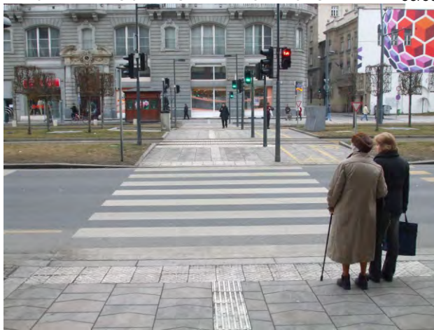
297-298. a kivitelezéskor nem fektették le a taktilis jelzésrendszert, hanem azt utólag kellett pótolni
