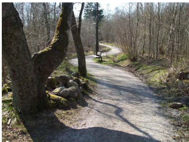
717-718. akadálymentesen használható stabilizált burkolat kifejezetten akadálymentesnek jelölt útvonalon; enyhén lejtős szakaszokkal
