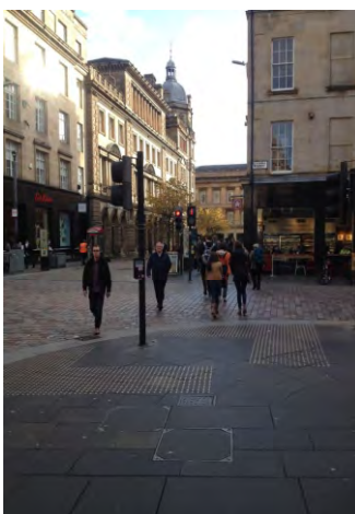
358-360. a rávezetés is figyelmeztetőelemekkel történik; az átkelést az útburkolaton nem jelölik, így hiányzik a vizuális kontraszt
