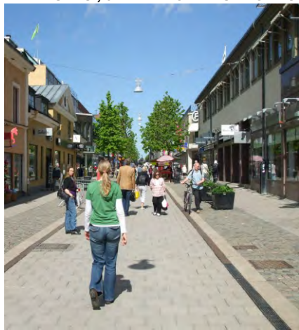
205-207. a vonalas vízvezető rácsokat sok látássérült ember használja természetes vezetősávként (rácsköz < 2cm)
