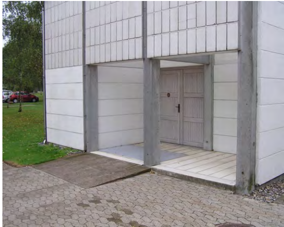
104-105. finom megoldású rámpa előlépcső áthidalására Utzon templománál (műemléki érték)
