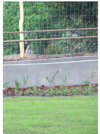
78-80. akadálymentes rámpa szolgál a lépcső (ld.56-57.) alternatívájaként, kerékvető és duplasoros korlát, amelyen a kéz nem akad meg
