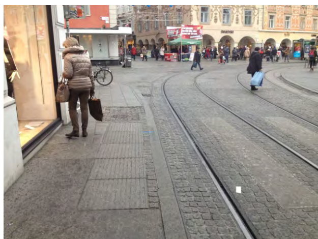
393. vezetőjelzés figyelmeztető funkcióban; szinkontraszt nincs
