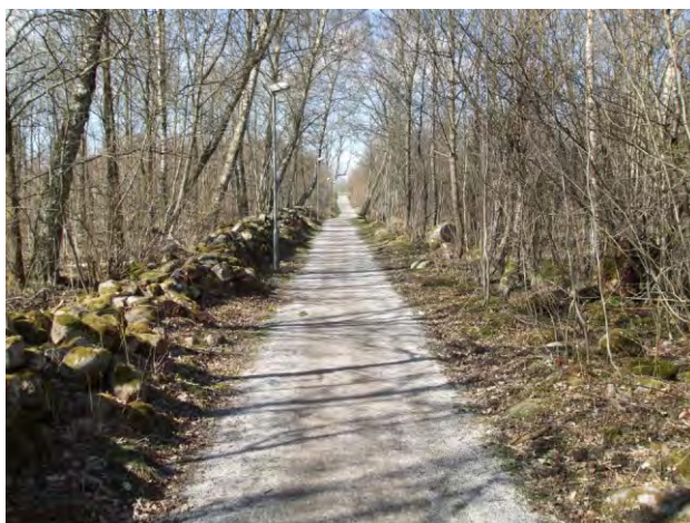
717-718. akadálymentesen használható stabilizált burkolat kifejezetten akadálymentesnek jelölt útvonalon; enyhén lejtős szakaszokkal
