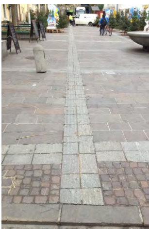
246-248. a taktilis jelzések integrálódnak a járófelületeken egyébként alkalmazott burkolati mintába
