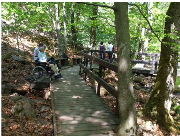
761-762. kikerülési pontok akadálymentes pallóösvényeken, amelyeknek a térbővületében pihenőpadok is elhelyezhetők
