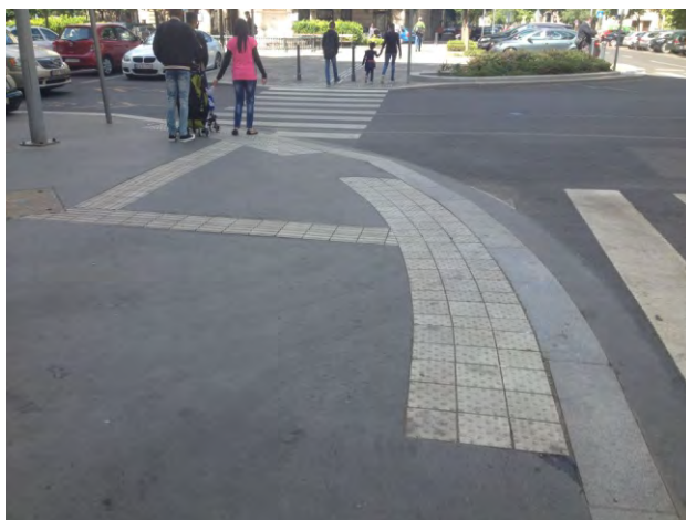
305-306. a Szabadság tér felé közeledve a hagyományos, térkő-elemes taktilis jelzésrendszert alkalmazták...
