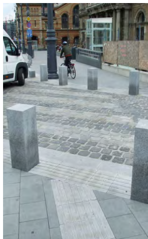
269-270. vezetőelemek cseréje figyelmeztetőelemekre
