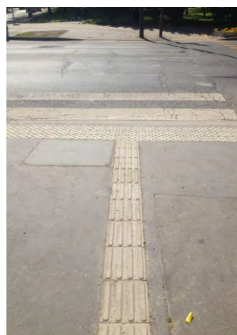
261-262. a fehér jelzés könnyen koszolódik, ezért a kontraszt megőrzése érdekében tisztítani kell
