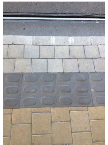
473-475. a zónahatár-jelzés először az 1-es villamos felújításakor jelent meg a peron biztonságos oldalának jelzésére
