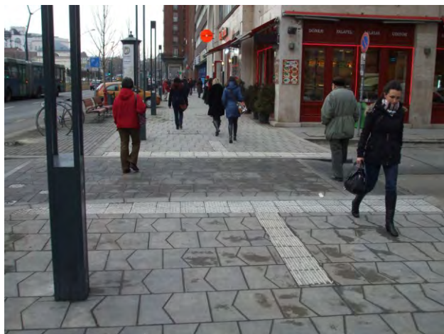
285-286. az átkelőkre való rávezetés az átkelő két oldalán egymással szemben legyen; a járdára időközben mobil akadályok kerültek
