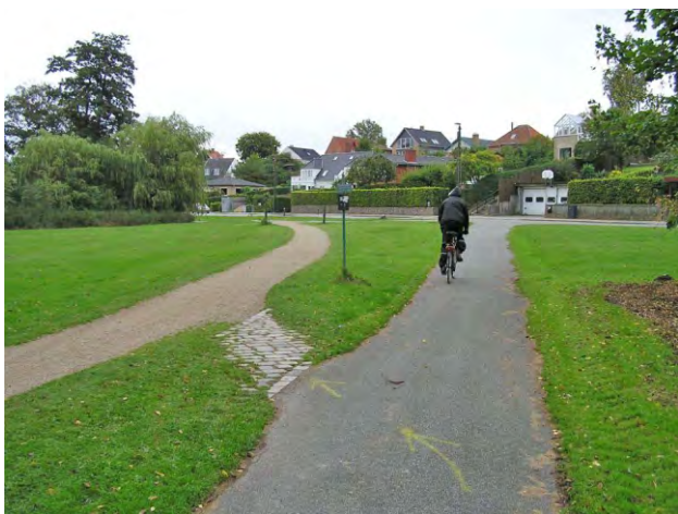
524. a gyalogút stabilizált, a kerékpárút aszfalt burkolatú
