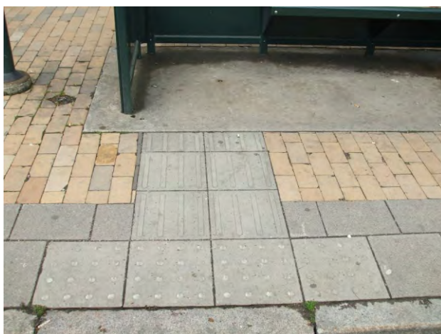
455-456. első ajtó helye TWSI-vel jelölve; a fedett utasváróban kerekesszékeknek is elegendő szabad hely a pad mellett
