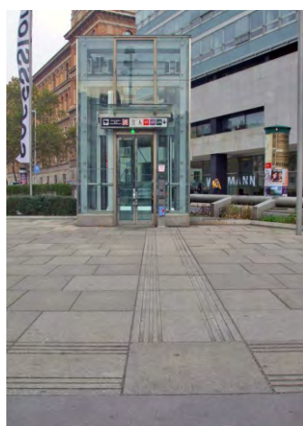
225-227. a Bécsben használt, csak taktilis kontrasztot nyújtó jelzésrendszer egyedi vezetőelemmel
