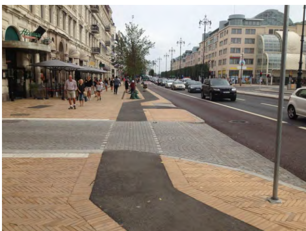
336-337. a kerékpársávot is jelölni kell a látássérült közlekedők biztonsága érdekében
