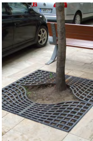
111-114. a meglévő fák törzsének szűkös a beépített faveremrác; a fiatal fa törzse sérülni fog; a földlabdás növény rosszul elültetve
