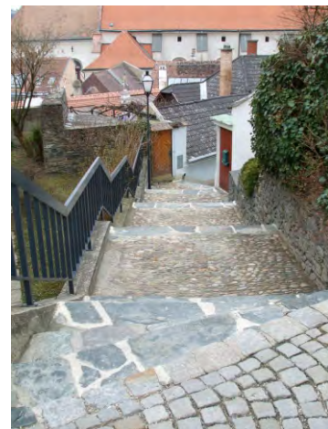
51-52. enyhe kontraszt a lépcsőfokok és a lépcsőpihenők burkolata között
