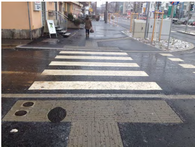
378-379. helyiek beszámolója szerint a graz-i TWSI egy 20 éves, következetes rendszer; a kerékpársávon is átvezet; elágazásnál figyelmeztető
