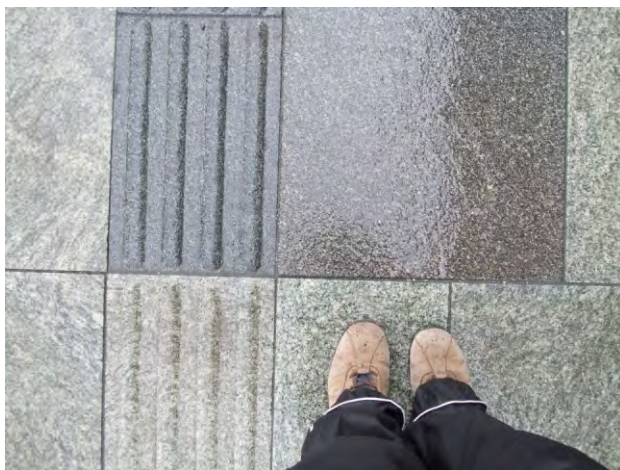
340-341. a burkolati rendszerbe illő egyedi taktilis jelzésrendszer; a vizuális kontrasztot az átkelő útburkolati színezése adja
