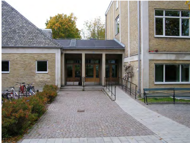
96. utólagos, a környezetbe simuló akadálymentesítés
