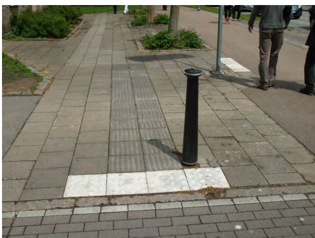
326-327. lépésszélességnél keskenyebb figyelmeztetésáv; a vezetés nem színkontrasztos, csak a figyelmeztetés
