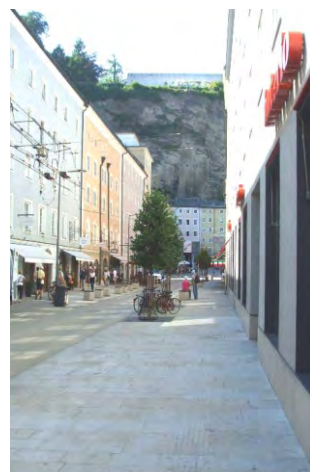
208-211. a burkolatba mart kialakítású vezetősáv nem érzékelhető, és kültérben hajlamos az eltömődésre; hiányzó szinkontraszt
