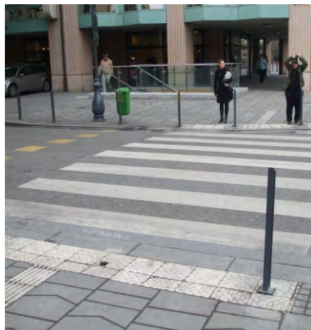
271-272. hiányzó taktilis jelzésrendszer pótlása
