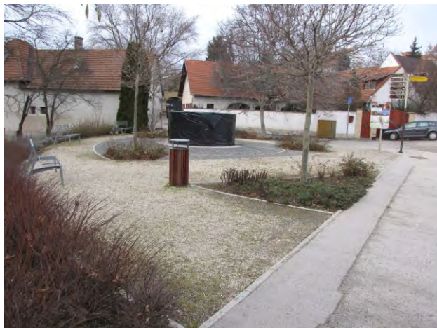
542. stabilizált burkolat városi szövetbe integrált zöldfelületen
