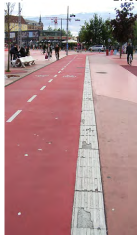
240-241. vezetősáv egyik oldala a kerékpárúton, ami nem biztonságos, hanem veszélyes útvonal!
