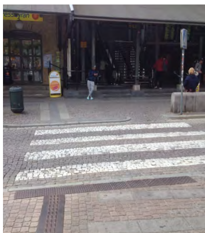
322-323. terméskő-burkolatba integrált fémelemes jelzésrendszer
