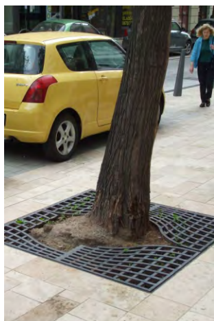
111-114. a meglévő fák törzsének szűkös a beépített faveremrác; a fiatal fa törzse sérülni fog; a földlabdás növény rosszul elültetve
