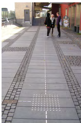
242-245. terméskő burkolatba integrált egyedi taktilis jelzésrendszer; egy vezetőborda nem érzékelhető; a fenntartás hiánya
