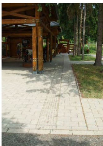
732-734. taktilis jelzés bemutatóközpont térkőburkolatában: épületek környezetében a szilárd burkolat használata is indokolt lehet
