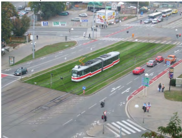
125. burkolatváltással elkülönített forgalmi sávok
