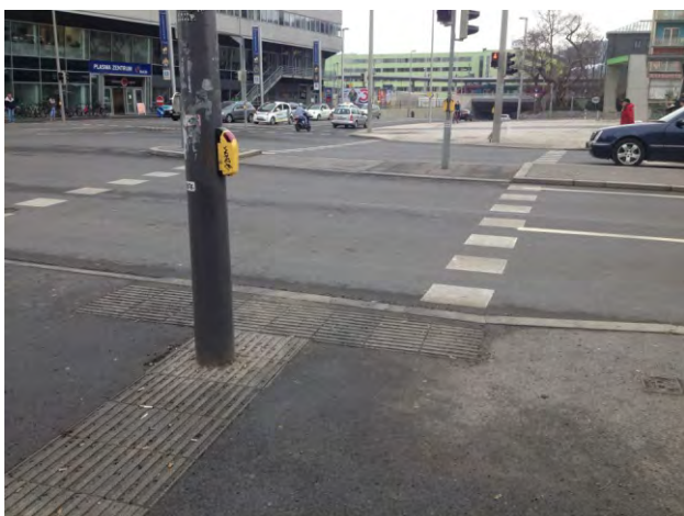
380-381. a vezetősáv közvetlenül objektumokra (jelzőlámpa, követhető lábamat) vezet rá, tehát azokat nem tekinti akadálynak...
