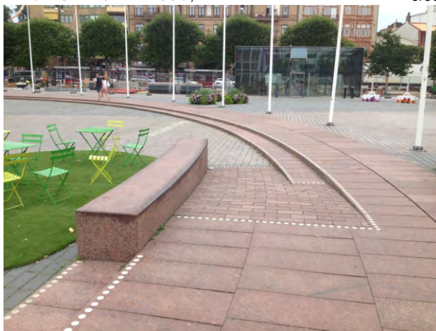
66-67. lépcsőbe integrált rámpa kontrasztos színezésű éljelöléssel, taktilis jelzés nem található
