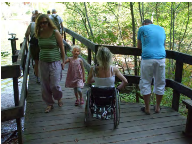
761-762. kikerülési pontok akadálymentes pallóösvényeken, amelyeknek a térbővületében pihenőpadok is elhelyezhetők
