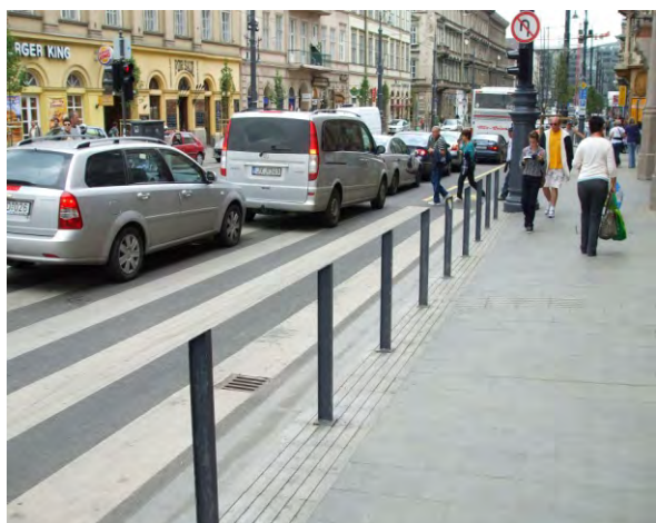
266-268. 2010-ben vezetősávot helyeztek el a kiskörúton figyelmeztető funkcióba, majd az érintettek észrevételei alapján ezt javították
