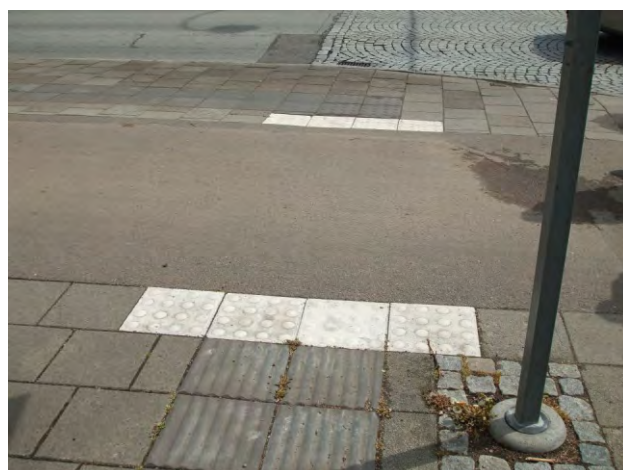
326-327. lépésszélességnél keskenyebb figyelmeztetésáv; a vezetés nem színkontrasztos, csak a figyelmeztetés
