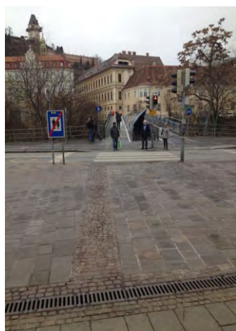
389-391. CWSM vezető- és figyelmeztetősáv teresedésről megtalálandó gyalogátkelőhöz
