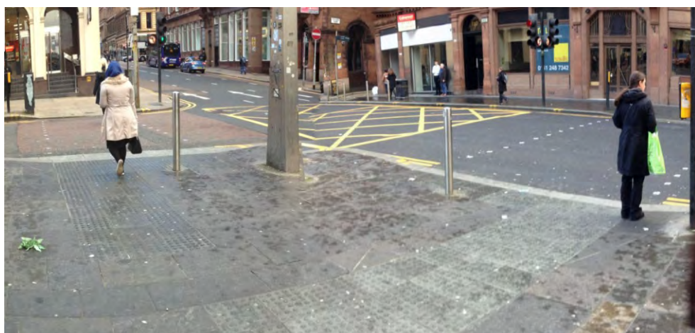
354-355. a rávezetés is figyelmeztetőelemekkel történik; a vörös szín hazai tapasztalatok szerint nem megfelelő kontrasztú
