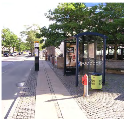
450-452. a járdán kialakított, színében nem kontrasztos TWSI figyelmeztetőjelzés mutatja az első ajtó helyét; a kerékpárosok figyelnek
