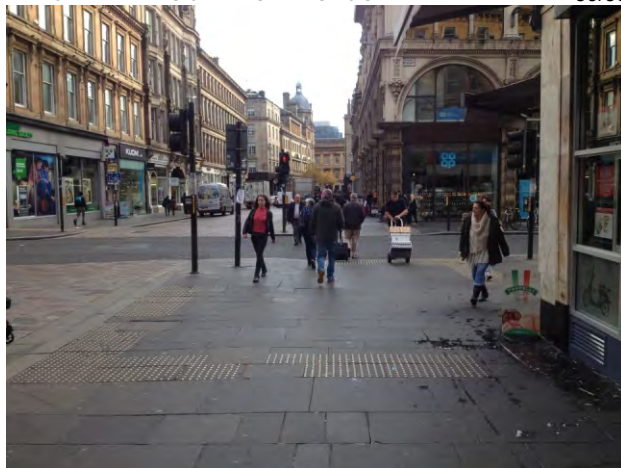
356-357. hazai tapasztalatok szerint a raszterben rakott figyelmeztetés mérsékeltén alkalmas vezetésre, de emiatt figyelmeztetésre kevésbé
