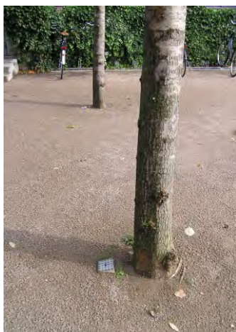
543-545. történeti kertekben, parkokban a megfelelő kialakítás és fenntartás mellett akadálymentes stabilizált burkolatok terjedtek el
