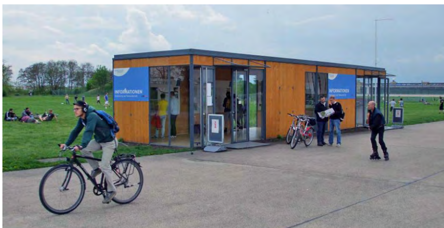
596. köztéri illemhely elhelyezésére is alkalmas épület közparkban
