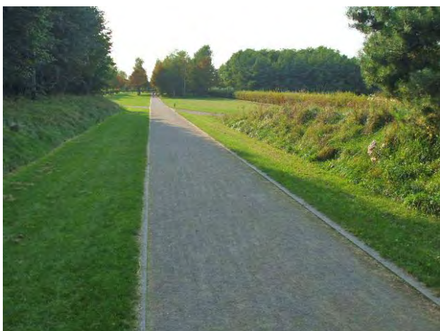
522. jól karbantartott kerékpárút stabilizált burkolaton
