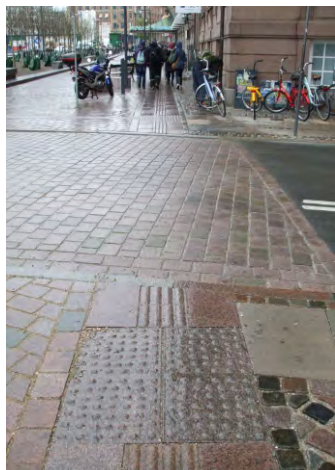
342-343. a járdaburkolathoz illő egyedi taktilis jelzésrendszer; vizuális kontraszt az útburkolaton sincs 344. rendhagyó dizájnban megfér
