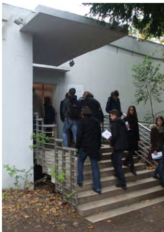
90-91. utólagos, mobil rámpával megoldott, az épület arcúthoz is illeszkedő akadálymentesítés
