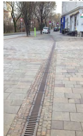
205-207. a vonalas vízvezető rácsokat sok látássérült ember használja természetes vezetősávként (rácsköz < 2cm)
