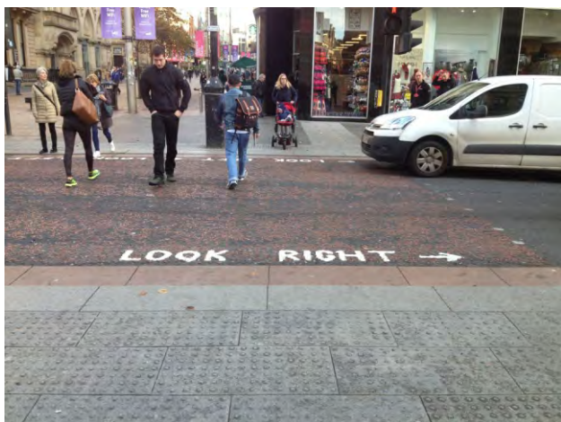
352-353. különböző kialakítású TWSI-k skóciai gyalogátkelőknél; az átkelés nem zebrával, hanem vörös színnel jelezve
