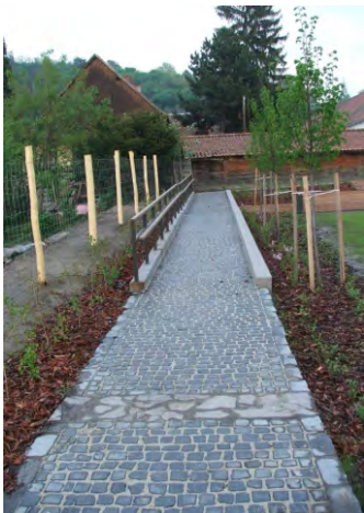
78-80. akadálymentes rámpa szolgál a lépcső (ld.56-57.) alternatívájaként, kerékvető és duplasoros korlát, amelyen a kéz nem akad meg
