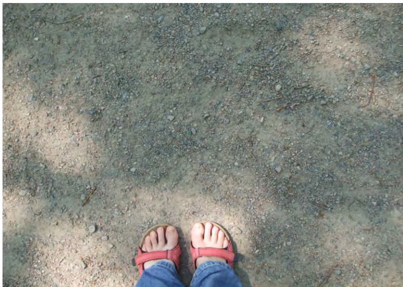
703-704. akadálymentesen, kerékpárral is használható stabilizált burkolat nemzeti parkban, a központi épület közelében
