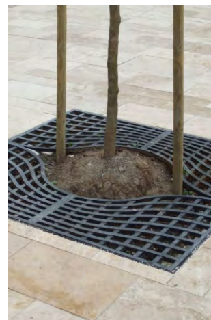
111-114. a meglévő fák törzsének szűkös a beépített faveremrác; a fiatal fa törzse sérülni fog; a földlabdás növény rosszul elültetve
