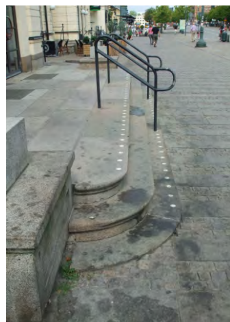
101-103. előlépcső és rámpa, a rámpa íves (kérdés: megfelelő-e a sugar-lejtés aránypár, vagy torzul a felület?), szíkontrasztos éljelölés
