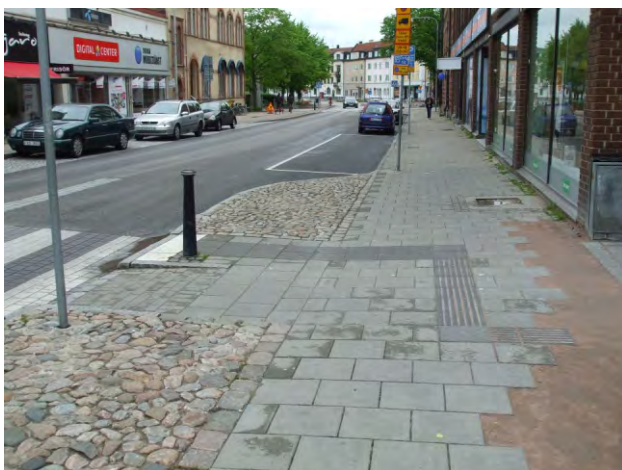
324-325. a látássérültek a süllyesztett szegélyt nem érzékelik, mégis a kiemelt szegély van taktilis figyelmeztetésával jelezve
