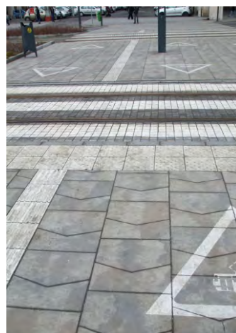
299-300. nem követték a terveket: a vezetősáv átkelőknél mindig figyelmeztetősávba fusson! magán az átkelőn hazánkban nincs vezetősáv
