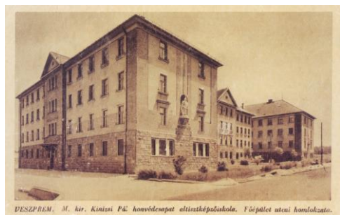
191. kép: A főépület utcai homlokzata
