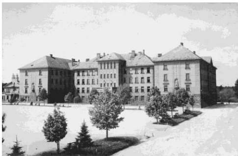
190. kép: Gyakorlótér az iskola kerti homlokzata előtt
