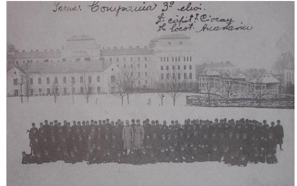
175. kép: Gyakorlótér az épület hátsó homlokzata előtt
